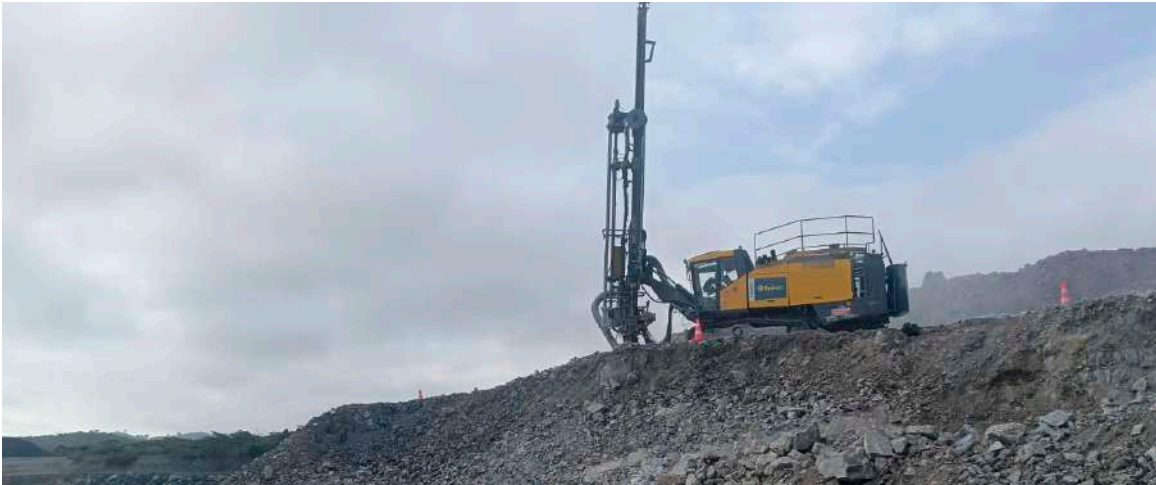
Figura 9. Equipos de perforación superficial
