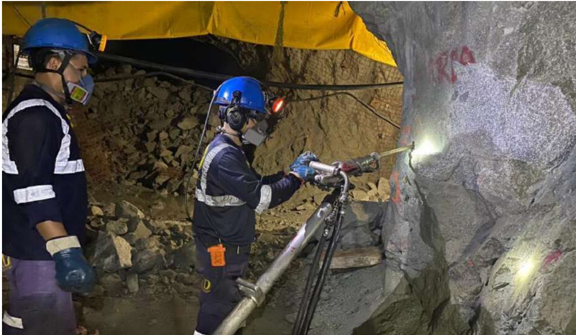
Figura 7. Perforación con martillo neumático bajo tierra.
