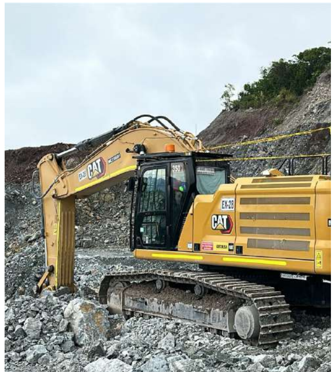
Figura 6. Retroexcavadora en operación
