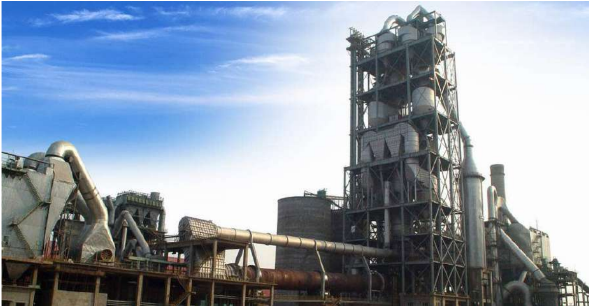
Figura 16. Planta cementera Fuente: Handakiln (2016).
