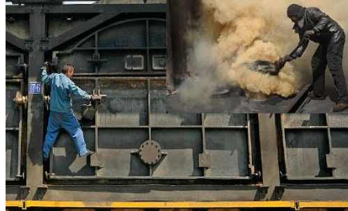
Modernizar hornos de coque
