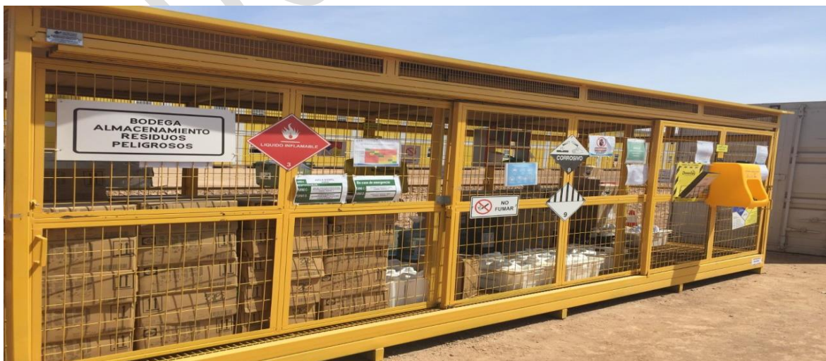
Figura 6-12 Caseta de Almacenamiento de Residuos Peligrosos
