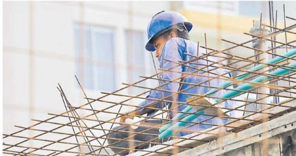
Trabajador en un edificio en construcción colocando las barras de acero.
